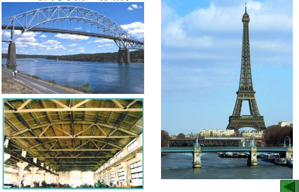
工程中多为梁、杆结构
